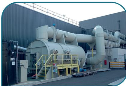
Les équipements étanches et la nouvelle installation de traitement de l'air augmentent le volume d'air traité sur site de 65% et permettent de supprimer les odeurs autour de l'usine.
